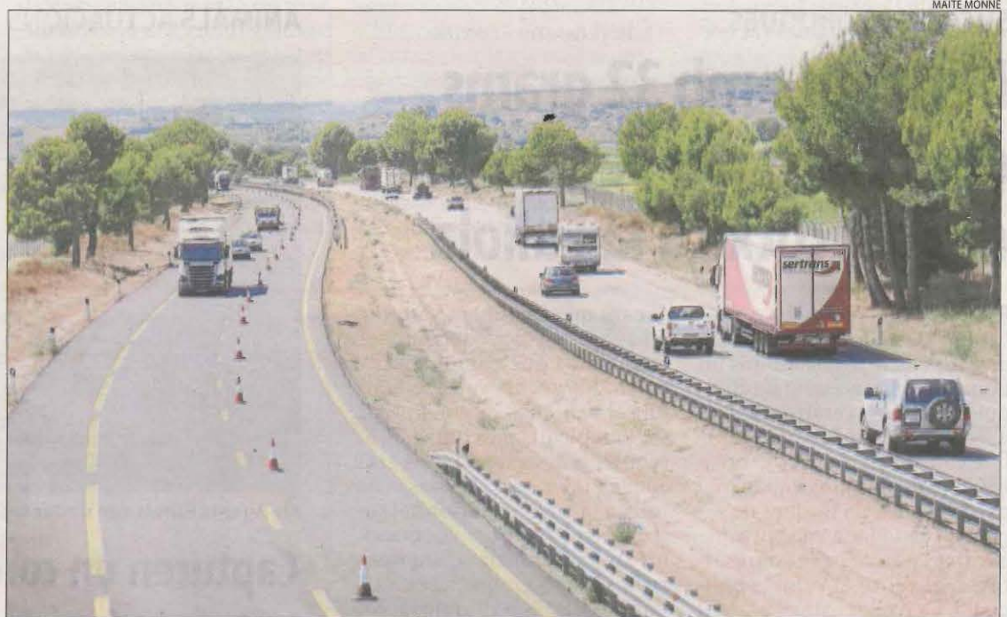
El tram de l'autovia que s'ha renovat (calçada esquerra), ja reobert ahir al migdia.
