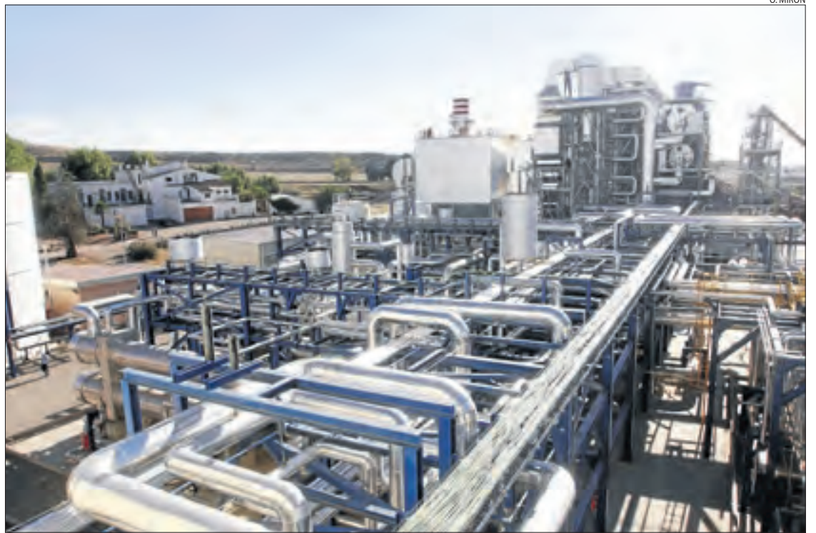
Imatge d'arxiu de les instal·lacions de la central termosolar de les Borges Blanques.
