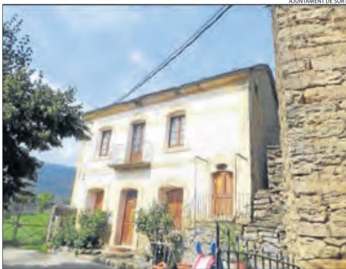
La façana de l'antiga escola d'Enviny, construïda el 1935.
