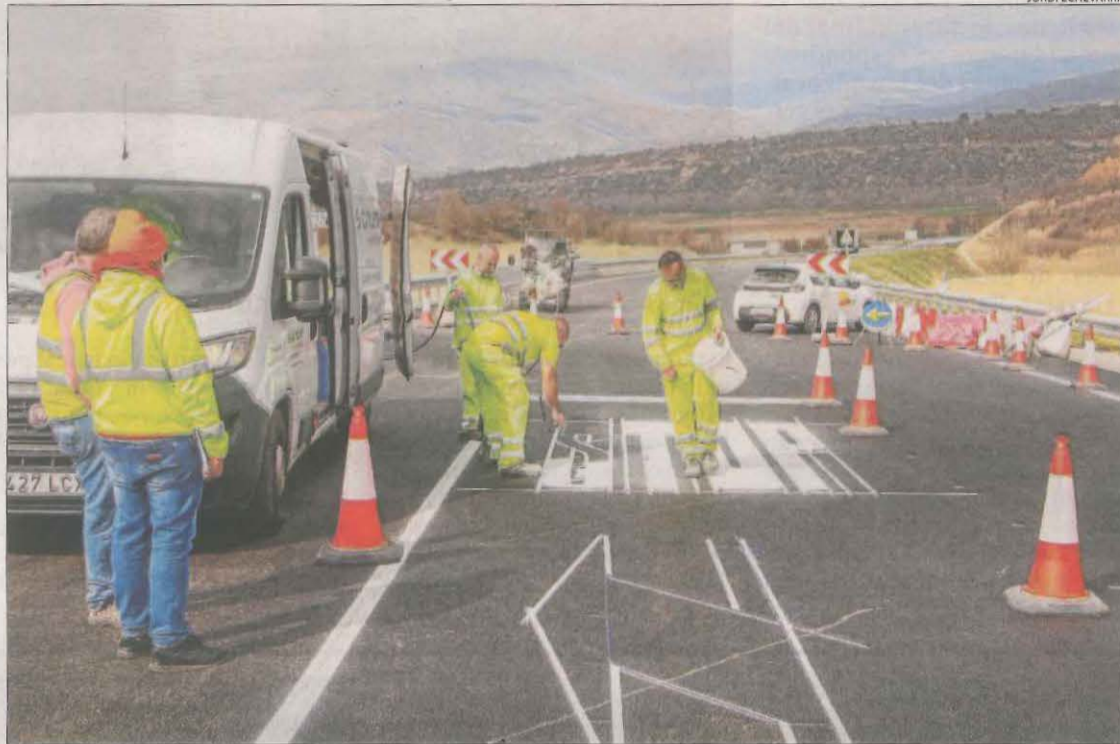
Els operaris treballaven ahir a pintar la senyalització horitzontal de la nova ronda d'Artesa de Segre.
