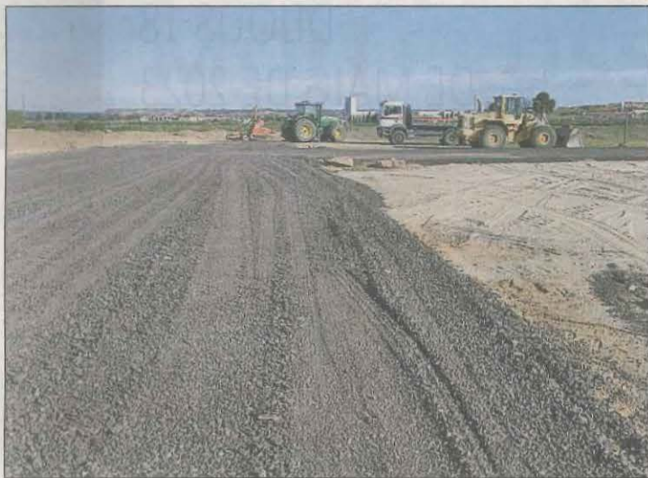
FOTO: Aj. Alcarràs / Imatge dels treballs que s'estan duent a terme
