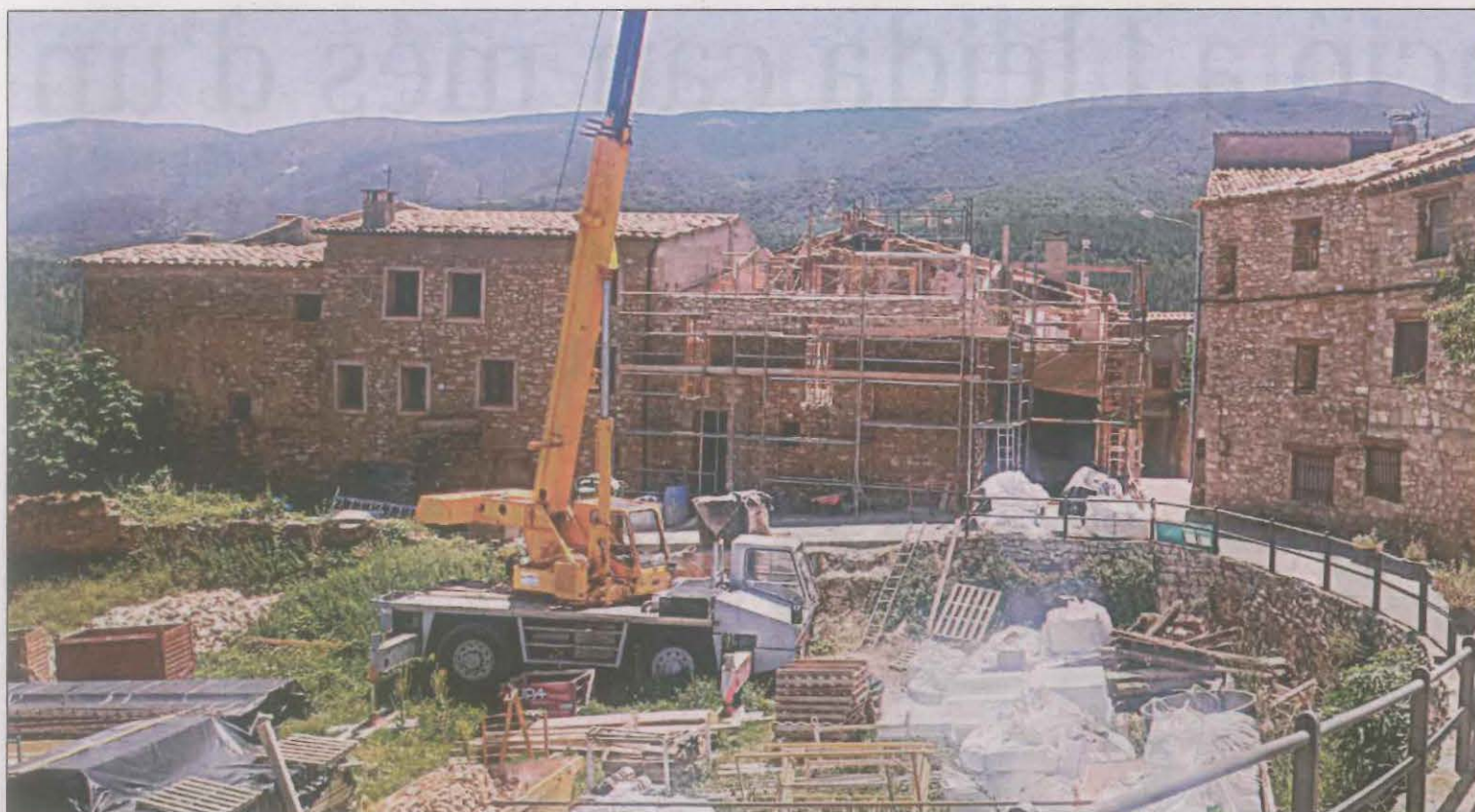
FOTO: Ajuntament de Sant Esteve de la Sarga / Una grua treballant en l'inici de les obres, que es poden allargar fins a la primavera del 2024
