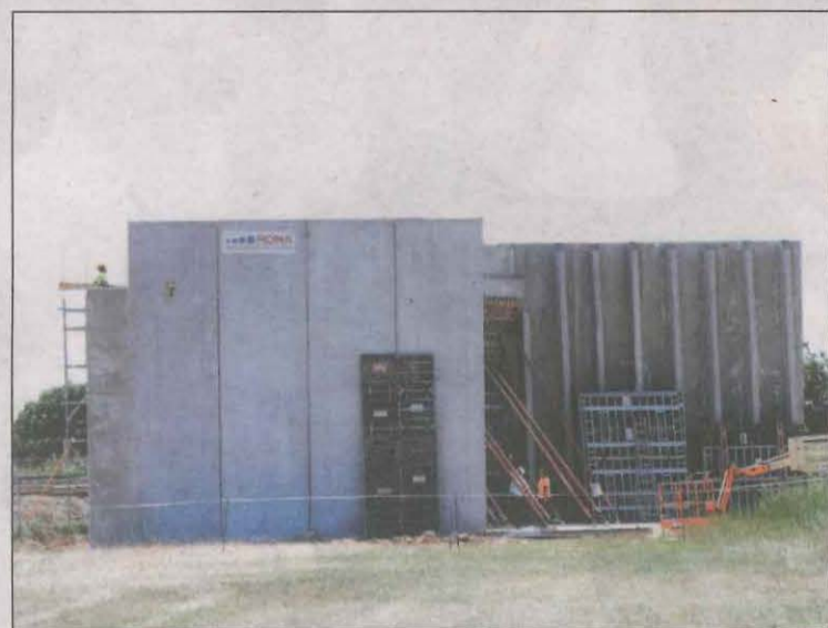
FOTO: Tony Alcántara / Feines per construir l'estructura del pont
