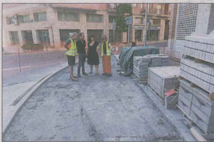
FOTO: L.M. / L'alcaldeessa Alba Pijuan va visitar ahir les obres del tram
