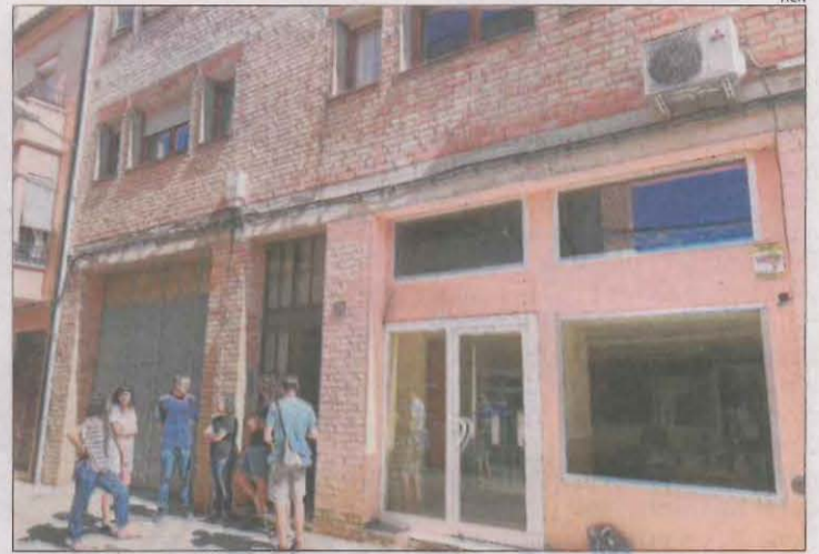
Els promotors, al bloc de pisos que es rehabilitarà.
