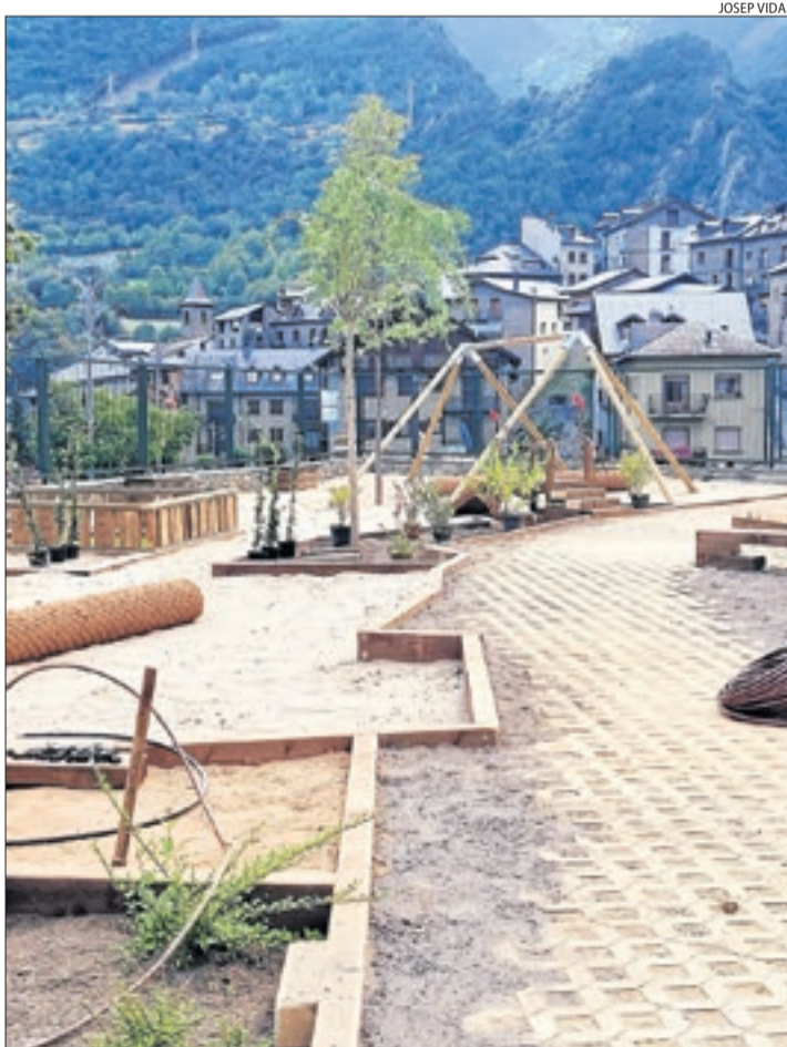
Les obres del pati de l'escola de Llavorsí.
