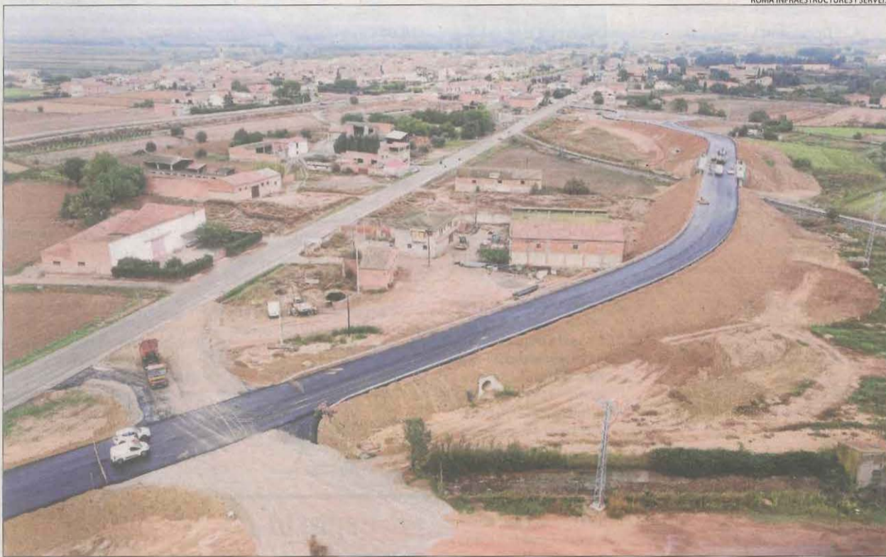
ROMA INFRAESTRUCTURES I SERVEIS
