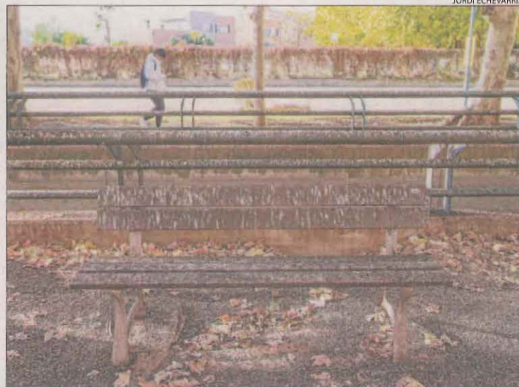
Un banc i la barana de l'avinguda del Canal, coberts d'excrements.
