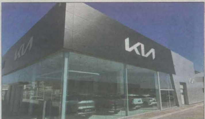
Noves instal·lacions de Kia Callesa, al polígon El Segre de Lleida.
