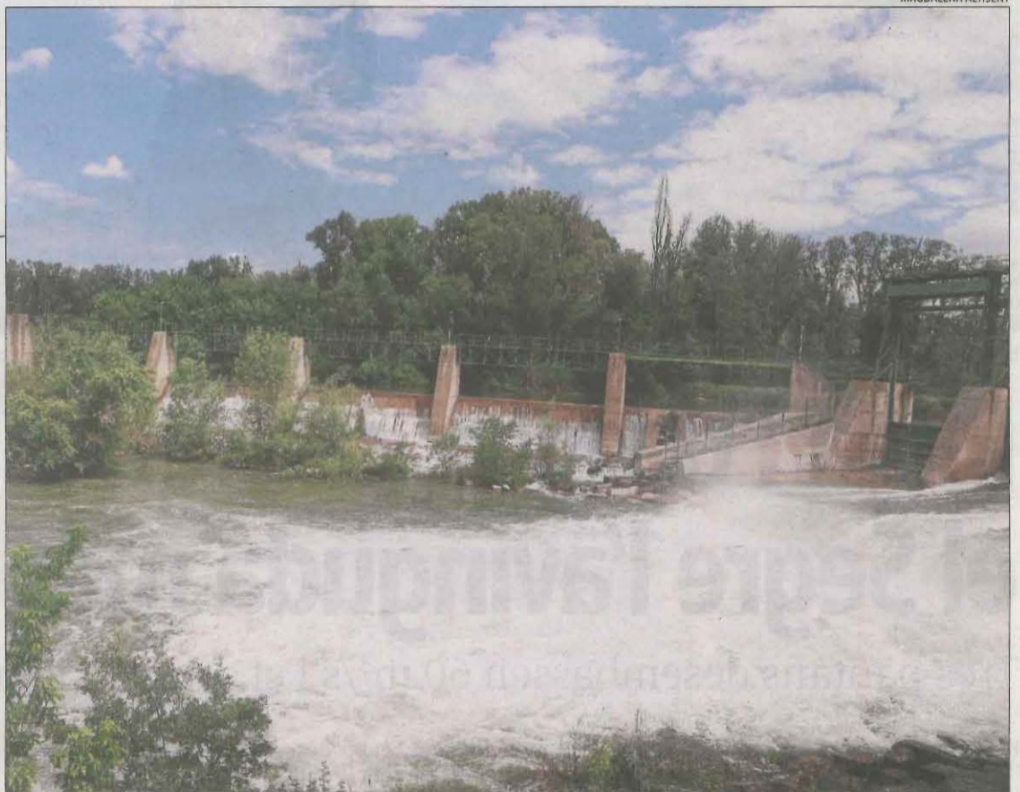
Endesa va desviar al Segre el cabal del canal de Seròs per una incidència tècnica a la central.
