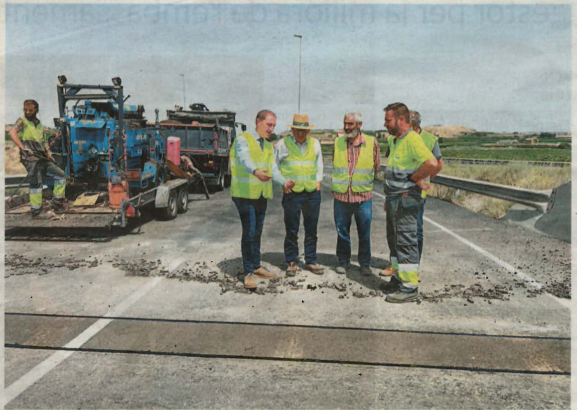
FOTO_ Transports Crespín ahir a l'A-2 mentre es realitzaven les darreres obres de millora
