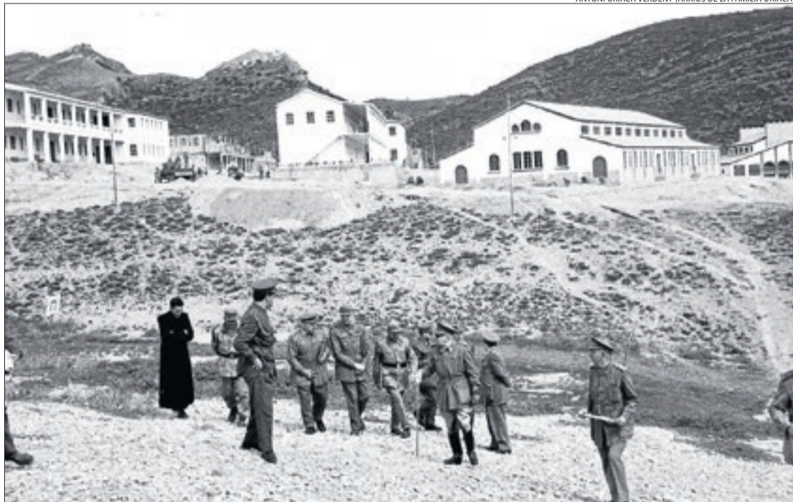
Els edificis en construcció per als quals van ocupar reclutes, molts d'ells paletes.
