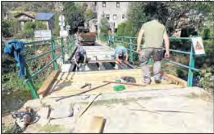
Els operaris treballant al pont d'Ainet de Cardós.
