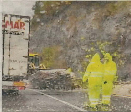
Operaris retirant la roca de l'N-230.
