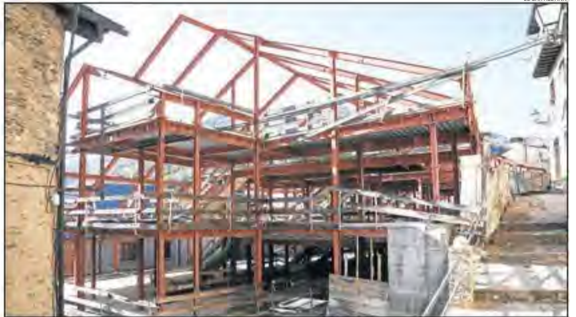
L'estructura de l'edifici al carrer del Mig de Rialp.
