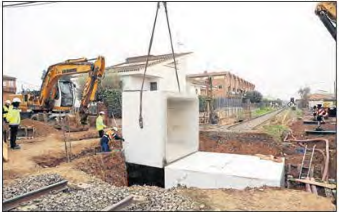
La col·locació dels blocs per construir el pas inferior va obligar a tallar les vies del tren.
