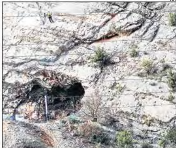
Treballs d'altura per instal·lar antiallaus en una boca de túnel.
