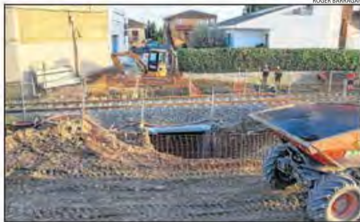
A Tèrmens, els operaris ultimen els accessos al baixador.
