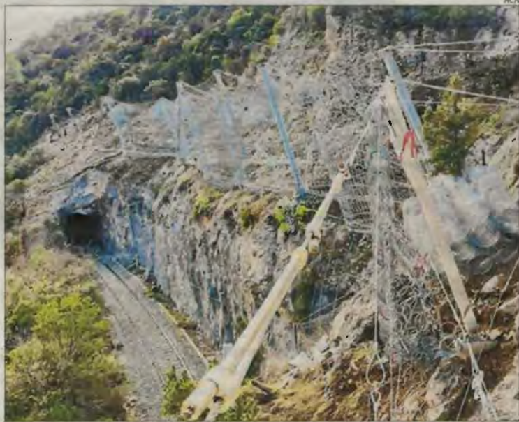
Els operaris ultimant els treballs en els pendents.
