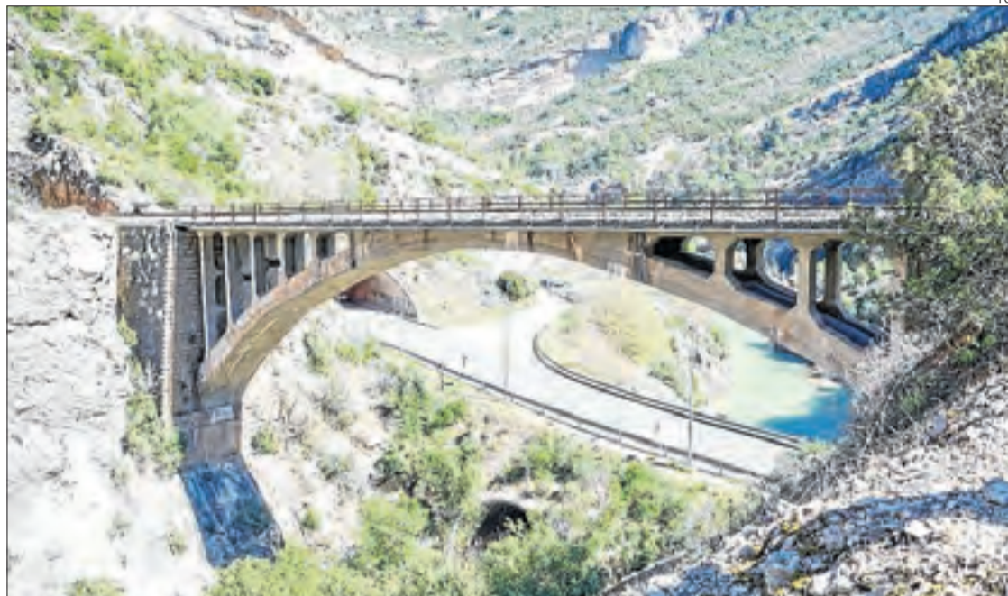
El pont del barranc del Bosc, entre Àger i Cellers-Llimiana, que serà reforçat.
