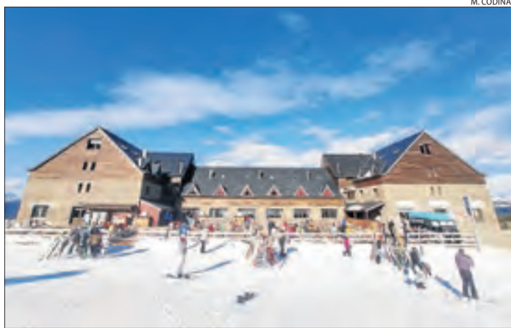
Vista general de l'hotel de Port Ainé, propietat de FGC.
