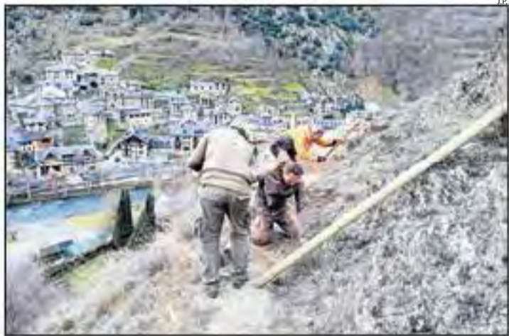
Els treballs per instal·lar la barana.
