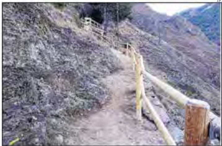
La barana de fusta ja col·locada.
