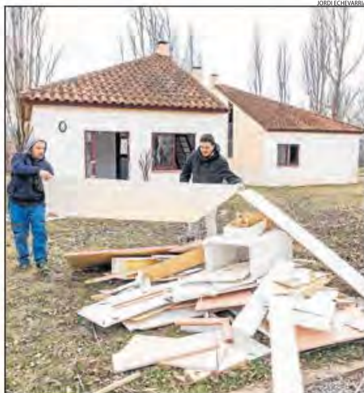
Neteja de l'interior dels bungalows abans de rehabilitar-los.
