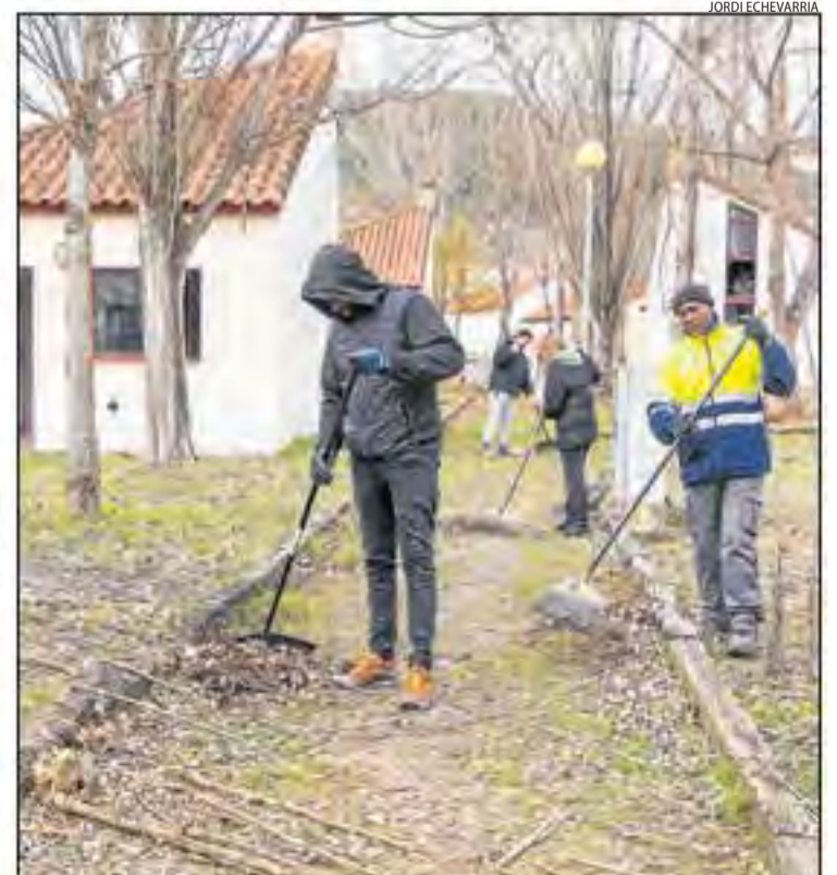
Tretze alumnes de l'FP dual de Construcció rehabiliten el lloc.
